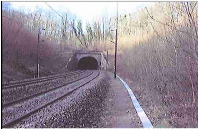
Photo : Martinsart tunnel
