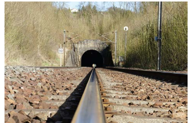
Photo : Montmédy tunnel
